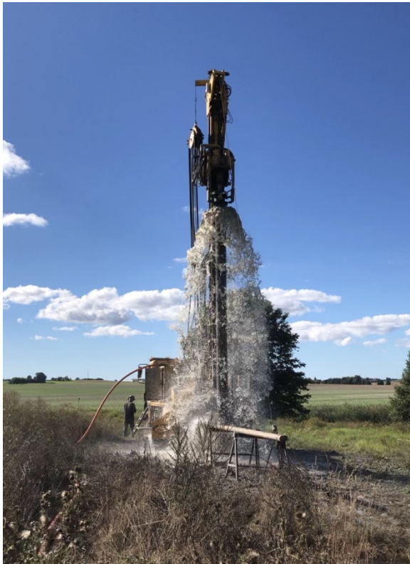
Borrning av brunn © Göran Persson, HP Borrningar.
